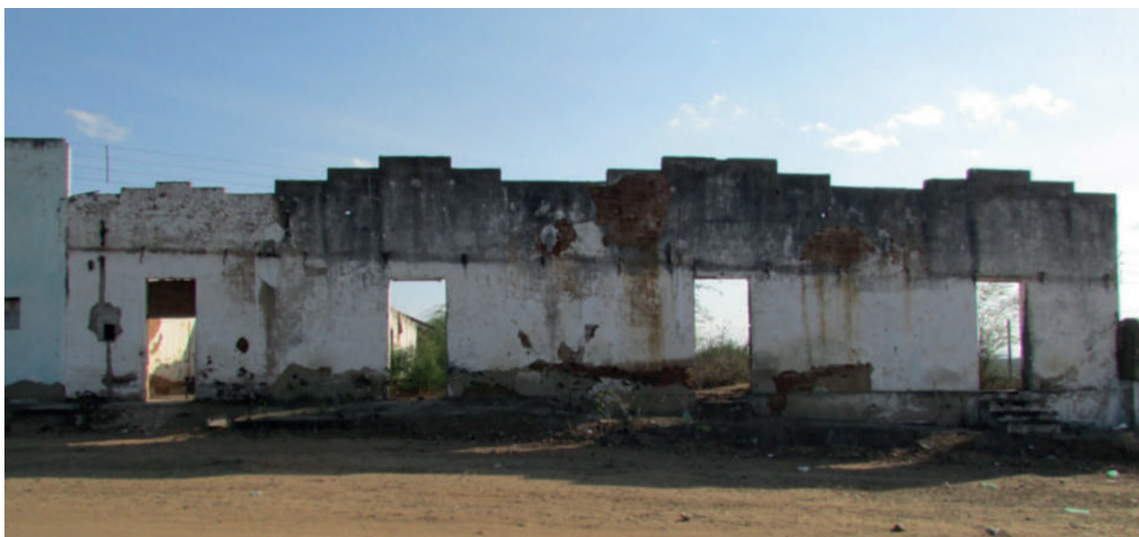
Ruínas da antiga Usina de Algodão
